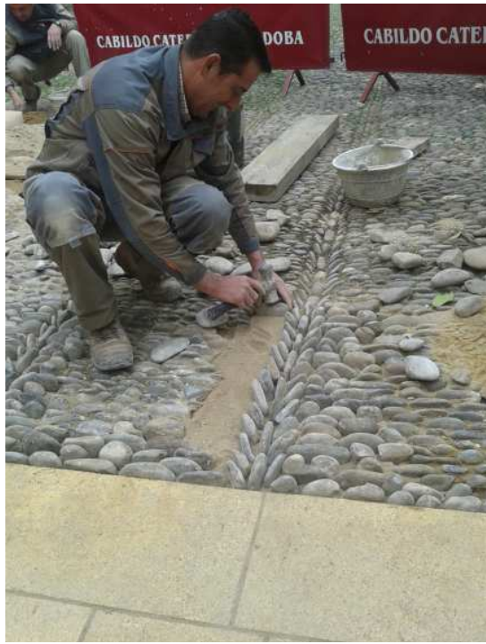
Figura III.2.3. Ejecución del pavimento de chino cordobés.
