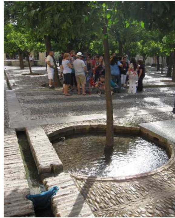
Figura III.2.4. Red de canales de riego del Patio de los Naranjos.
