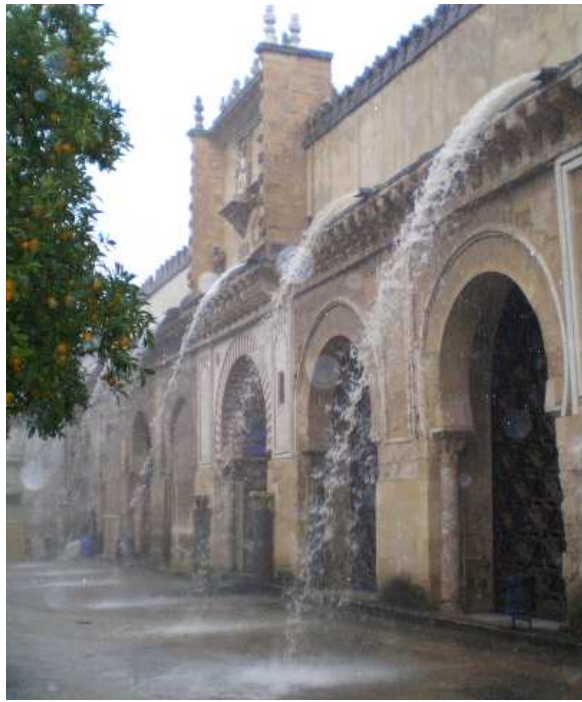
Figura I.2.80. Vertido de agua de lluvia al Patio de los Naranjos.
