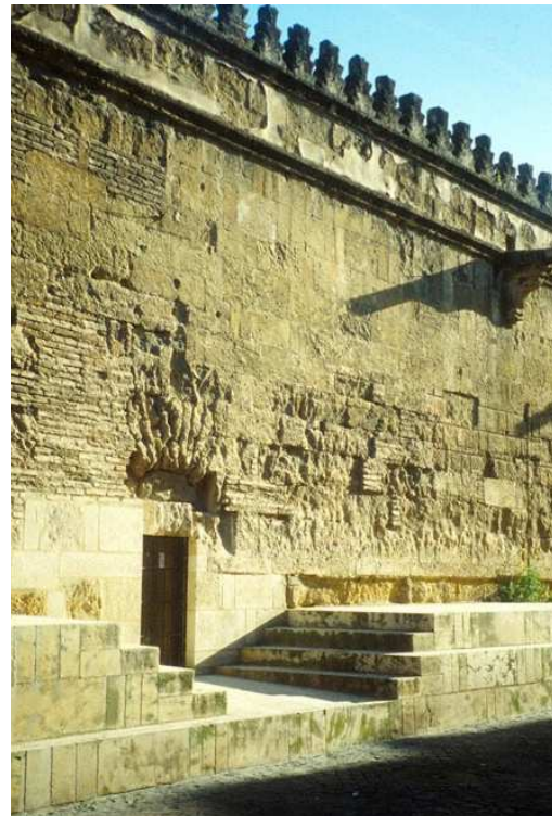
Figura I.2.79. Andén de la fachada septentrional.
