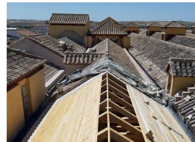
Figura I.2.65. Restauración de la cubierta de la nave 2.
