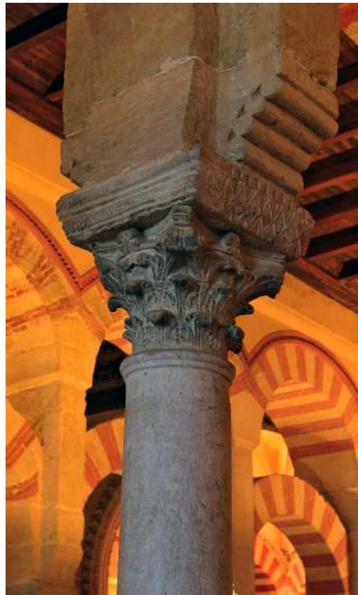
Figura I.2.46. Elementos reutilizados en la estructura de soporte.
