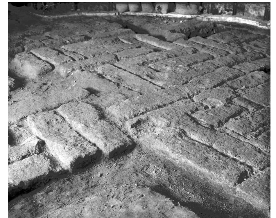
Figura I.2.40. Cimentación de al-Hakam II bajo la cripta de la Capilla de Santa Teresa. (Fernández Puertas, 2009, p. 114)
