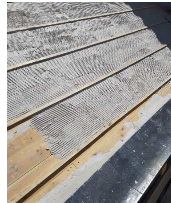
Figura III.2.1. Reparación de tablero con aplicación de alcatifa de yeso.
