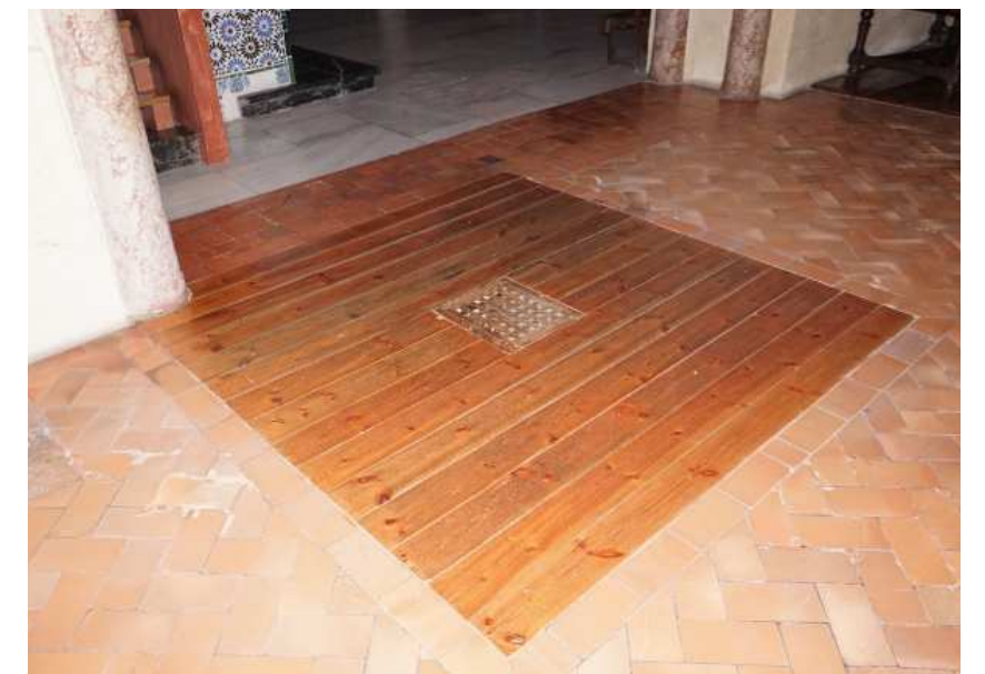
Figura III.2.6. Acceso con ventilación a uno de los registros de la fachada este de la ampliación de al-Hakam II.
