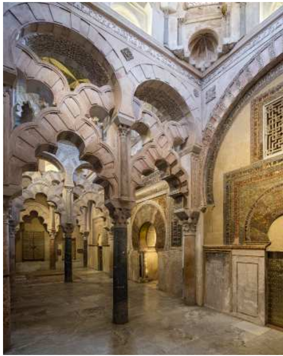
Figura I.2.50. Arcos cruzados bajo las bóvedas de la maqsura.
