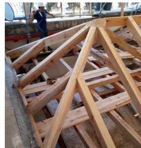
Figura I.2.64. Cubierta de la nave 1 en su encuentro con la fachada al Patio.
