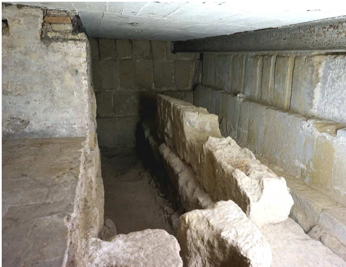
Figura I.4.2. Cara exterior del muro de quibla de Abd al-Rahman II.
