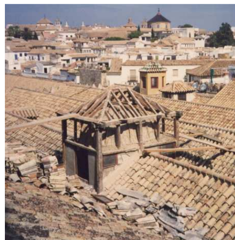
Figura I.2.63. Lucernarios en proceso de restauración.
