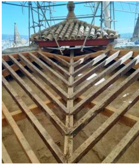
Figura I.2.66. Cubierta del Presbiterio en proceso de restauración
