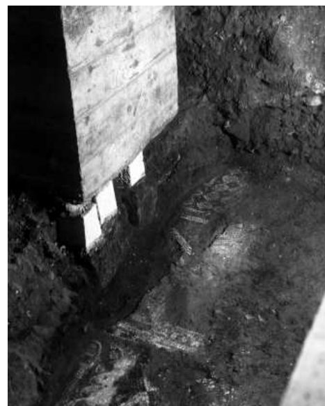
Figura I.2.36. Dado de hormigón de recalce. MACO, AFH, PO22_1_015.
