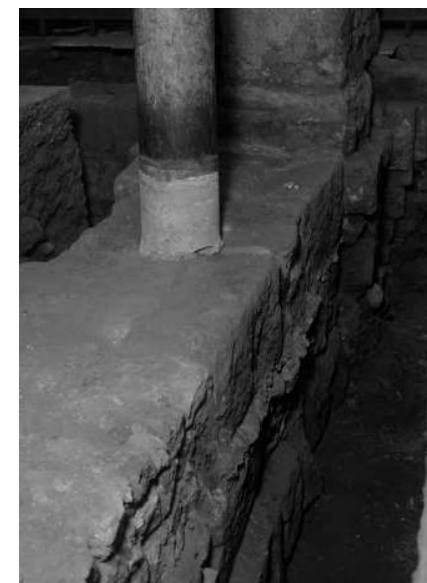
Figura I.2.37. Cimentación de arquería de la ampliación de Abd al-Rahman II. (Fernández Puertas, 2009, p. 90)
