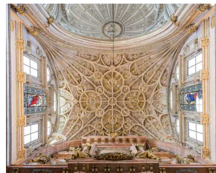
Figura I.2.72. Bóveda del Presbiterio.
