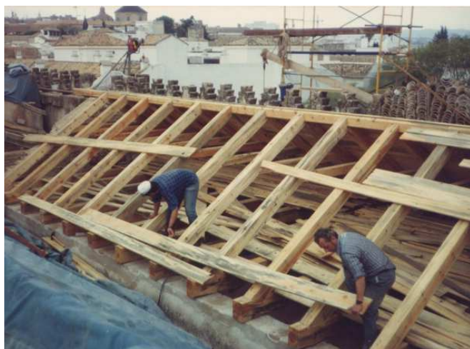
Figura I.2.62. Recuperación del trabajo con estructura de madera en la restauración de las cubiertas de las naves de Almanzor en los 80.
