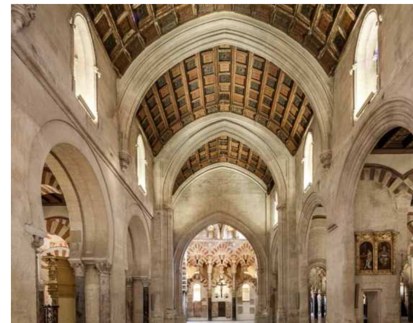
Figura I.2.75. Nave gótica con su artesanado de casetones de madera.
