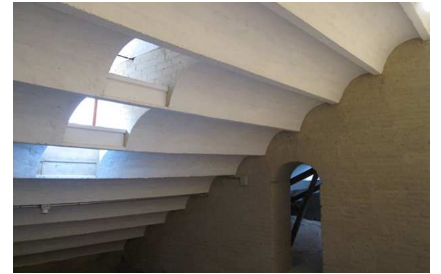
Figura I.2.68. Cubierta de viguetas de hormigón realizada por Félix Hernández alrededor de la nave del Coro.
