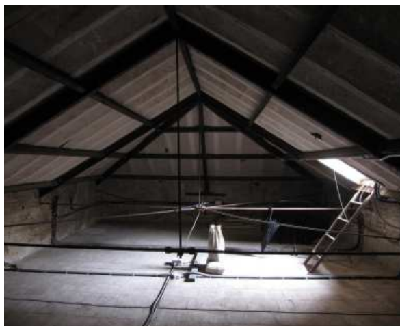
Figura I.2.60. Espacio bajo la cubierta realizada por Velázquez Bosco en la ampliación de al-Hakam II.
