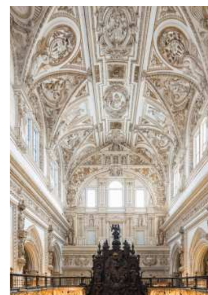
Figura I.2.71. Bóveda de la nave del Coro.
